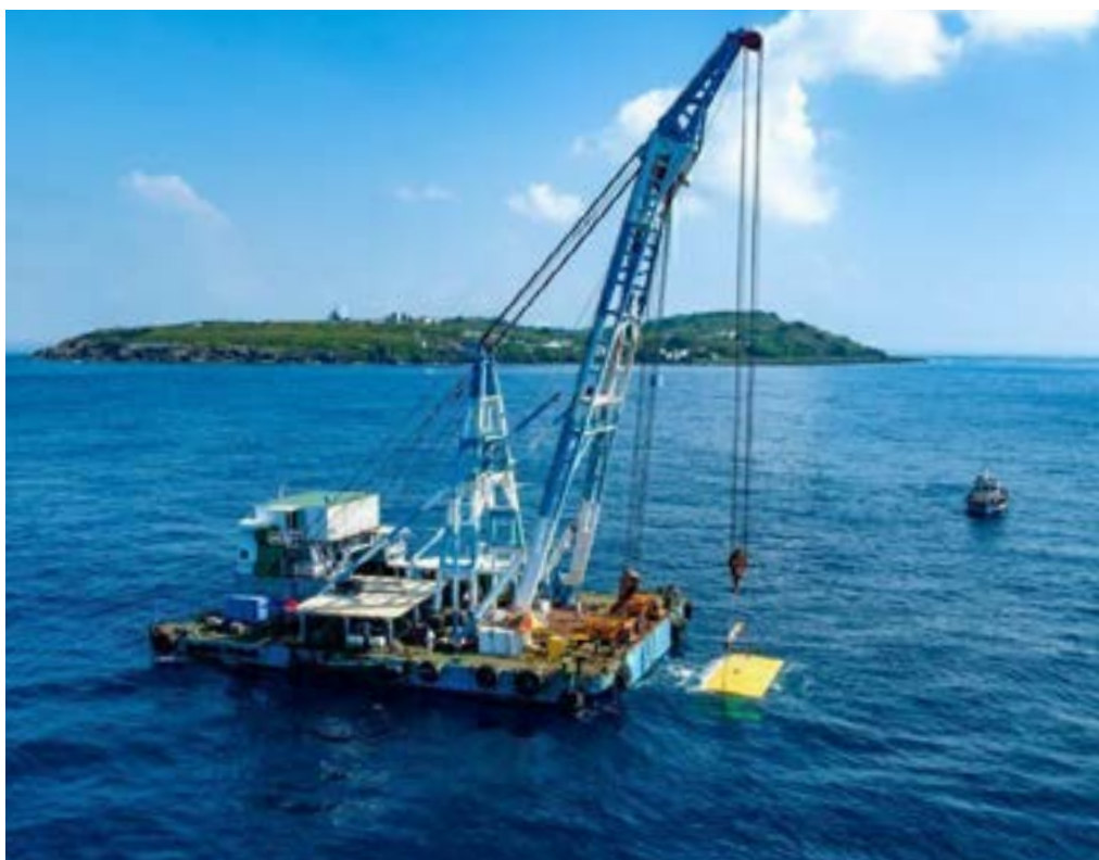
20kW 洋流能發電機組小琉球海域黑潮流域實海測試 資料來源：國家海洋研究院
