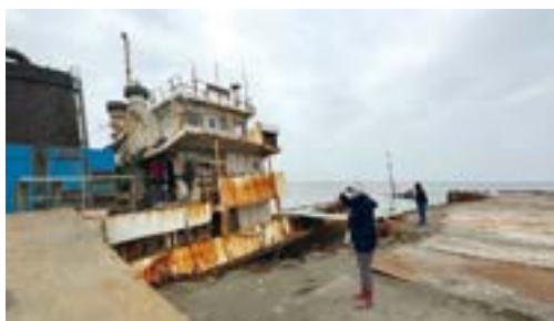
多芬輪旁鋪設舢舨平臺以陸域方式移除
