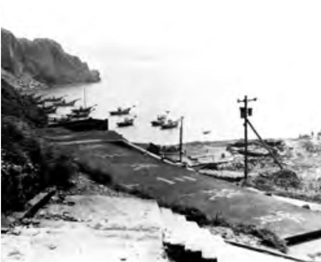
北濱國小校舍屋頂，可當道路通行。（賴茂盛提供）
