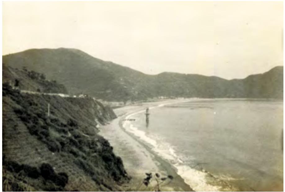
照片中央的柱子是吊車的水泥柱，當地人稱「牛奶」，專吊從南澳走海路拖來的木材。左側山上為蘇花公路，下方海岸線即「牽罟逝」。（南風澳文史工作室提供）
