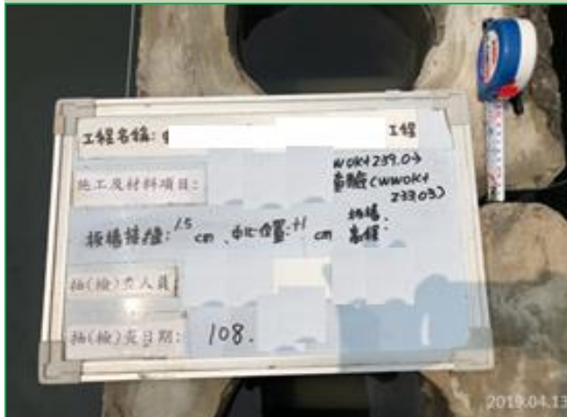
板樁接縫檢查
