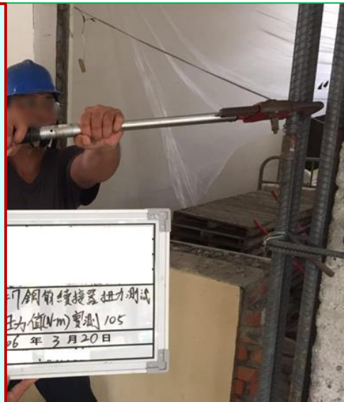
鋼筋續接器扭力板手測試
