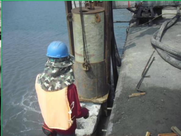
版樁樁錘施作
