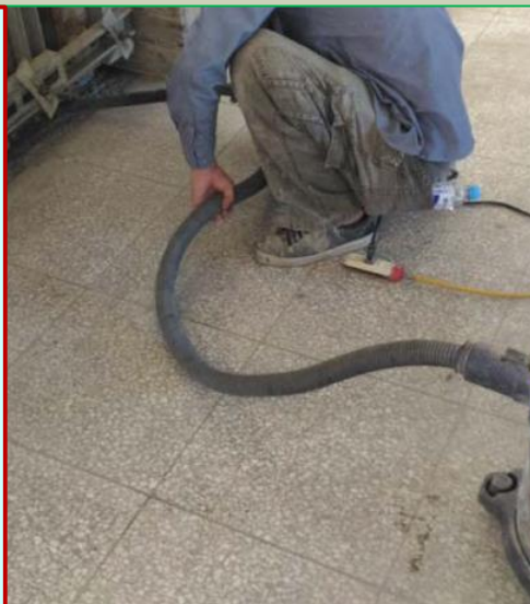
留設清掃孔 吸塵器清除粉塵或碎屑
