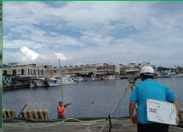
板樁打設高程檢查
