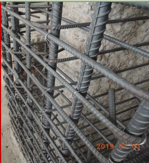
繫筋鉤住主筋 間距符合規定
