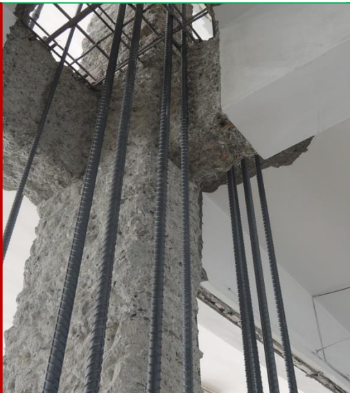
結構表面打毛至6mm粗粒度
