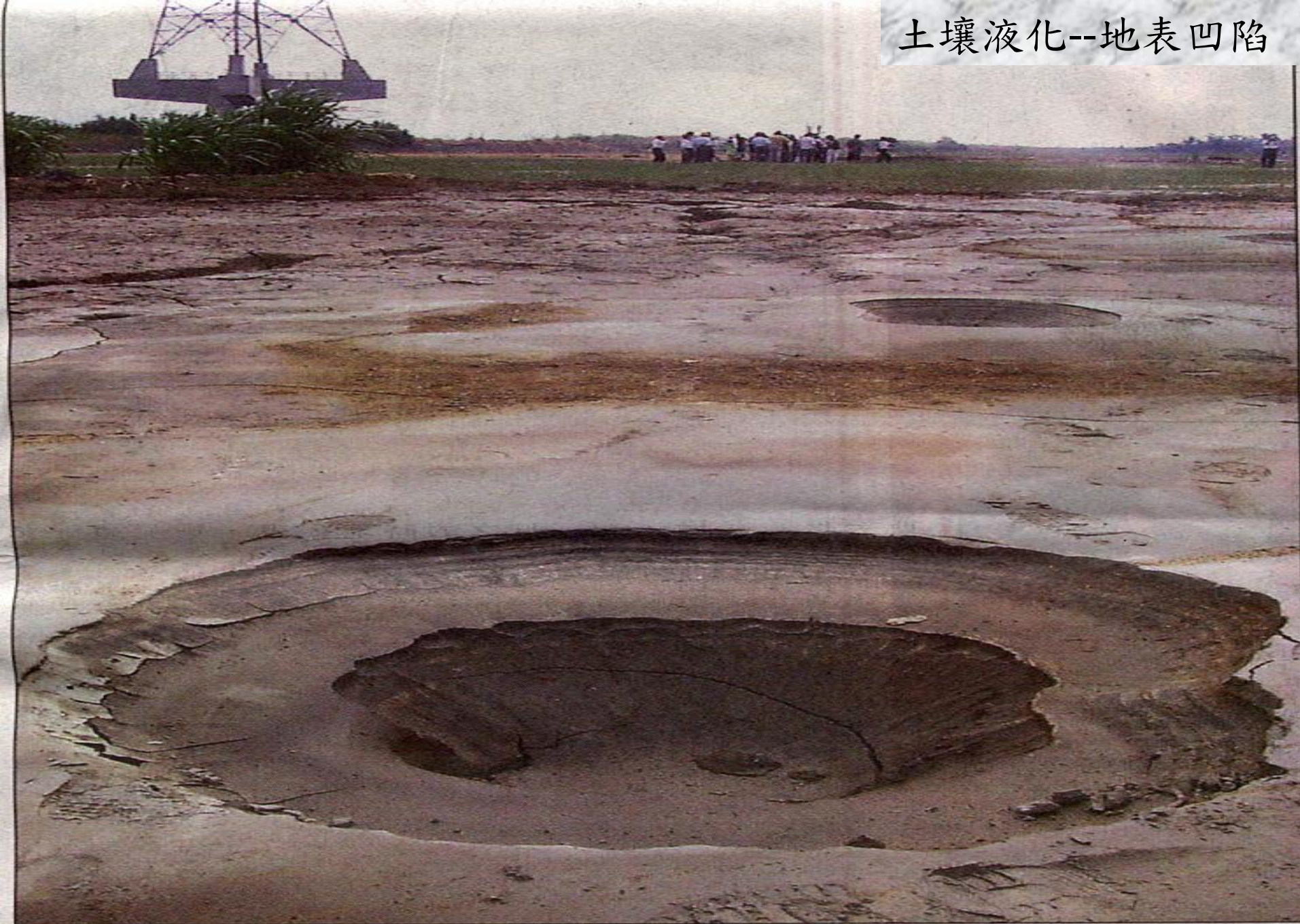
彰化縣伸港鄉大肚溪口高灘地，地震後出現裂縫和坑洞的奇特景觀，專家研判是土壤異化現象。 (記者張瑞楨攝)
