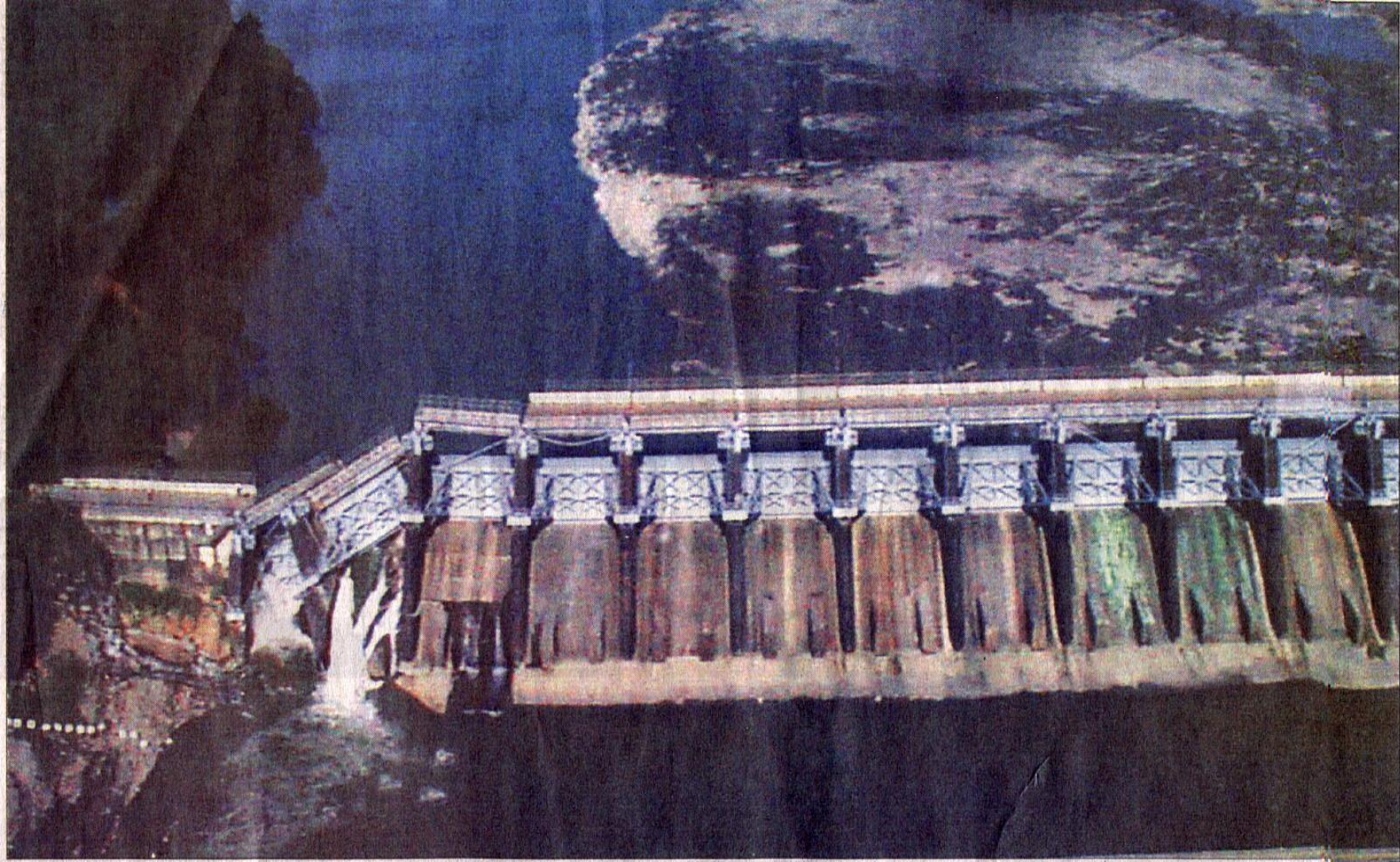
石岡水壩破裂--斷層經過--地表隆起
