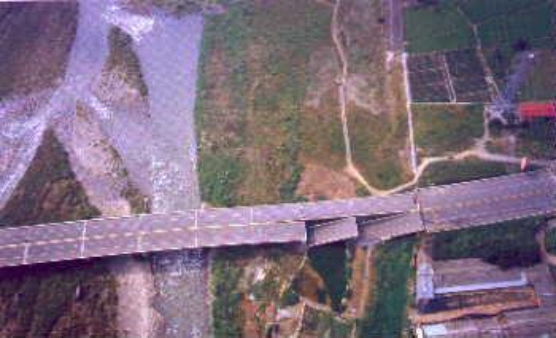
烏溪橋--橋面墜落
