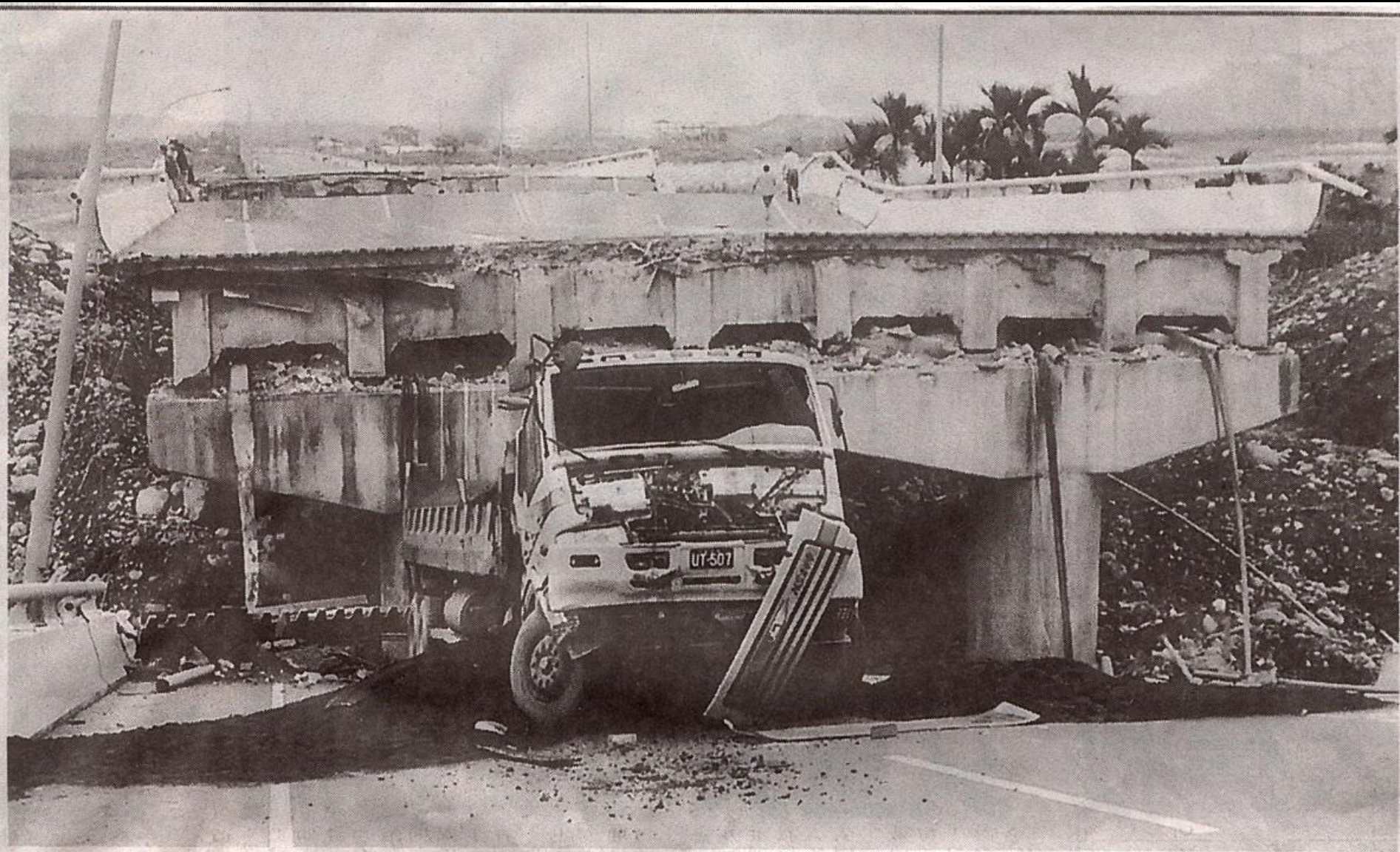
台三線名竹大橋禁不起強震肆虐，三分之一約七十公尺的橋面整個坍塌，一部大型砂石車閃避不及，隨橋面掉落在河床上。
