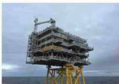
圖2 / 單樁式基礎與套筒式基礎
