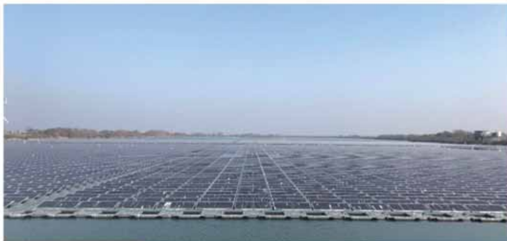
圖說／浮體式光電設施 圖片提供／陳璋玲
