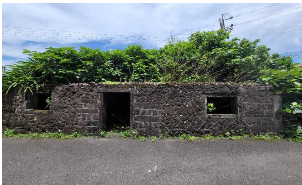
圖 1-13 不同砌法的牆面
